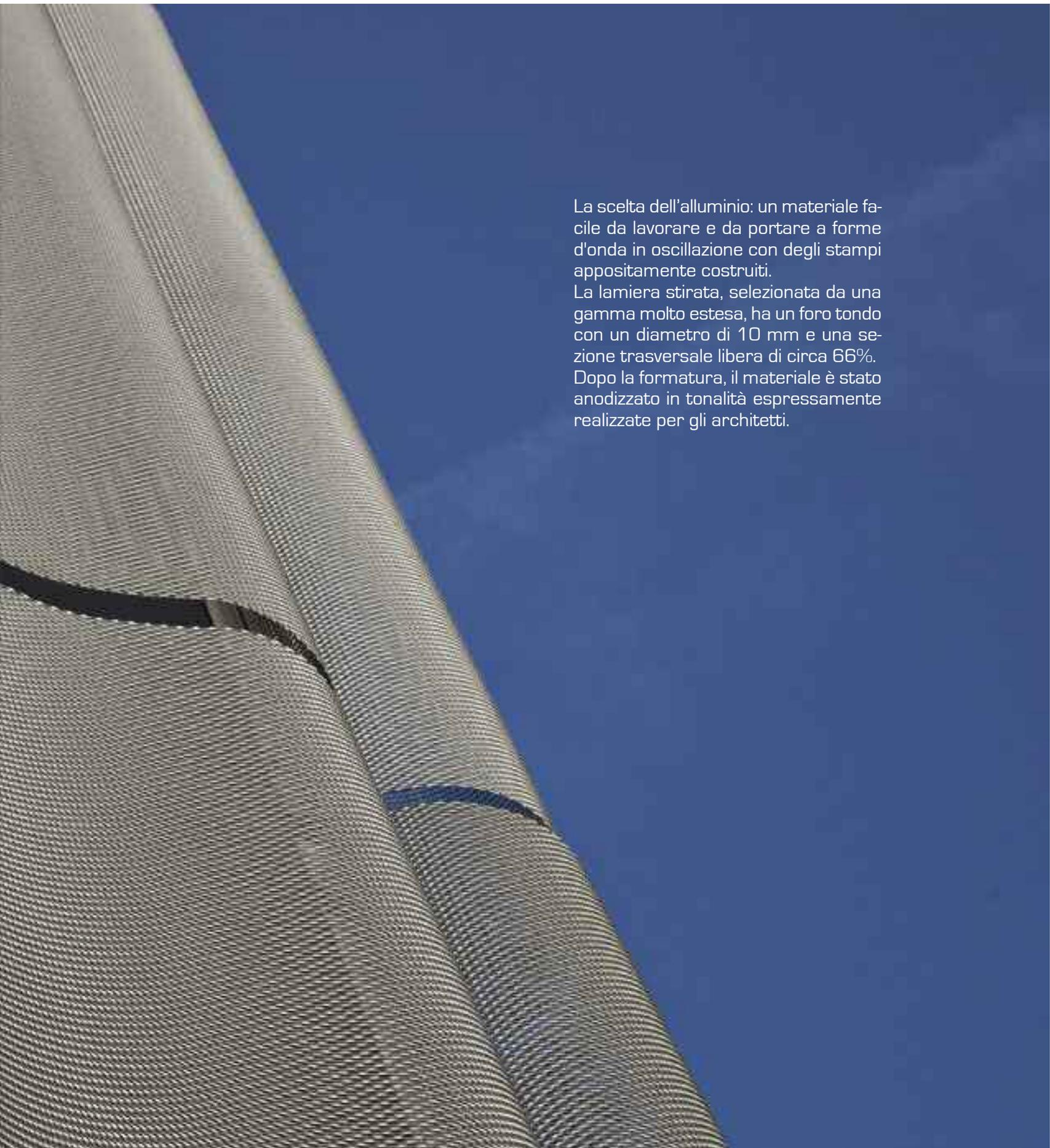
La scelta dell'alluminio: un materiale facile da lavorare e da portare a forme d'onda in oscillazione con degli stampi appositamente costruiti.
