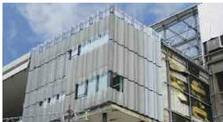
Una rete stirata Italfim con un foro di diametro 10 mm. È il materiale scelto per risolvere le esigenze estetiche e funzionali di tutti gli involucri esterni. On una doppia onda risultato di uno stampaggio modulare.
